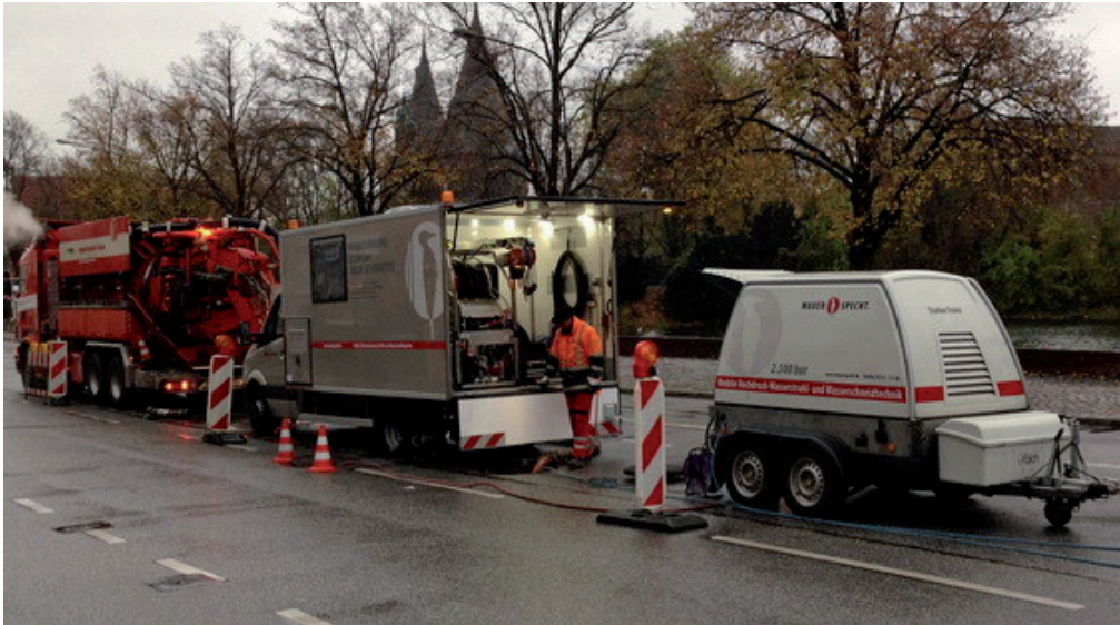
Bei der Kanalsanierung ist die Höchstdruck-Wasserstrahltechnik auf dem Vormarsch: Professionelle Kanalreinigung mit dem Wasserstrahlroboter Drain-Jet Robotics.
