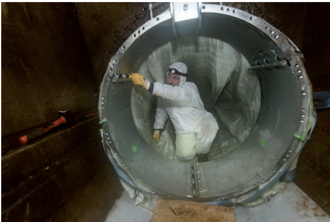
Sanierung DN1400 mit dem Alpha liner 1800. Der von Relineurope speziell für die Großprofilansanierung entwickelte dreiteilige Faltpacker wird gesetzt.
