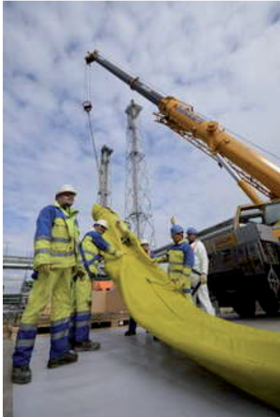
Einbau in Rekordzeit: Bereits 2014 wurde durch Swietelsky-Faber in einer Raffinerie in Bayern der erste Licht-härtende GFK-Liner in der Dimension DN 1600 installiert.
