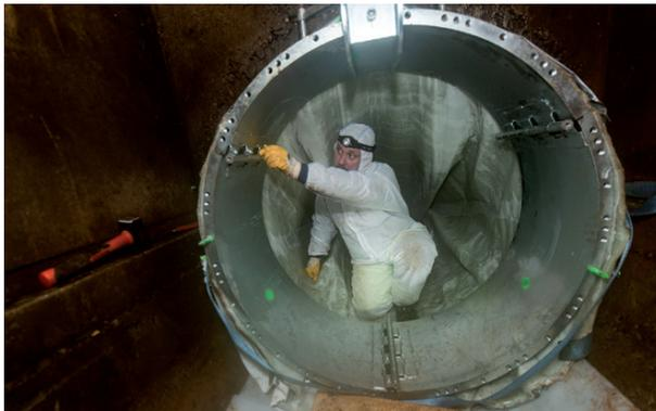
**Bild 1:** Sanierung DN1400 mit dem Alphaliner1800. Der von RELINEEUROPE speziell für die Großprofilisanierung entwickelte dreiteilige Faltpacker wird gesetzt
