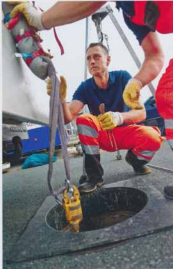
Sicher, sauber, schnell: Der Einzug eines Schlauchliners ist eine wirtschaftliche und technisch nachhaltige Sanierungslösung für Hauptkanal, Hausanschluss und Grundleitung. | Foto: Rainer Kiel Kanalsanierung GmbH
