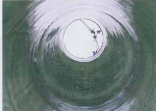
Ein dauerhaftes und zuverlässiges Sanierungsergebnis: Bei einer Schachtsanierung mit dem Vertilliner wird der Liner im Werk als Abbild des Schachtbauwerkes hergestellt. | Foto: Rohrsanierung Jensen
