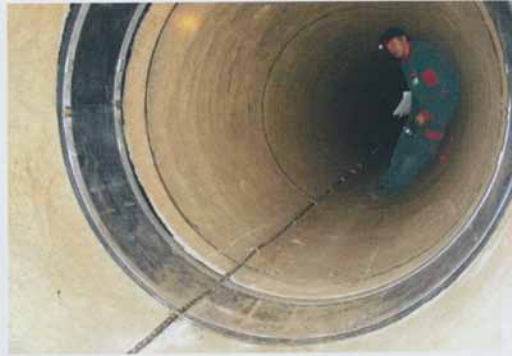
Mit Hilfe der WECO-Rohrinnendichtungen werden partielle Undichtheiten vorwiegend an Rohrverbindungen innenseitig abgedichtet. Die Gummimanschette wird rohrinnenseitig über die undichte Stelle gelegt und aufgestellt, so dass sich der undichte Bereich zwischen den beiden Dichtlippenprofilen befindet. | Foto: PBT GmbH
