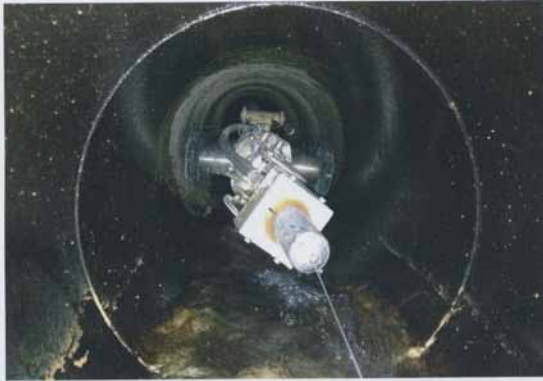
Entfernen von Inkrustation im Kanalsystem: Ein Höchstdruck-Wasserstrahlroboter wie der Drain-Jet Robotics dient zur Vorbereitung eines Hauptkanals für Reparaturmaßnahmen oder den Einzug von Schlauchlinern. | Foto: Mauerspecht GmbH
