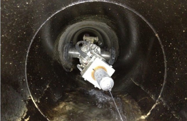
Bild 2: Entfernen von Inkrustation im Kanalsystem: Ein Höchstdruck-Wasserstrahlroboter wie der Drain-Jet Robotics® dient zur Vorbereitung eines Hauptkanals für Reparaturmaßnahmen oder den Einzug von Schlauchlinern
