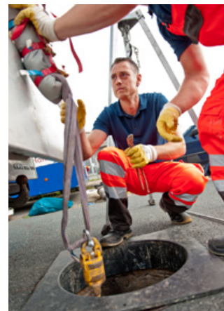
Foto: Rainer Kiel Kanalsanierung GmbH
