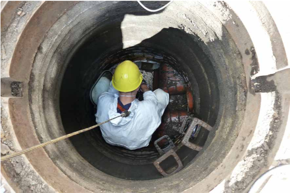
Sanierung eines Schachtes.
