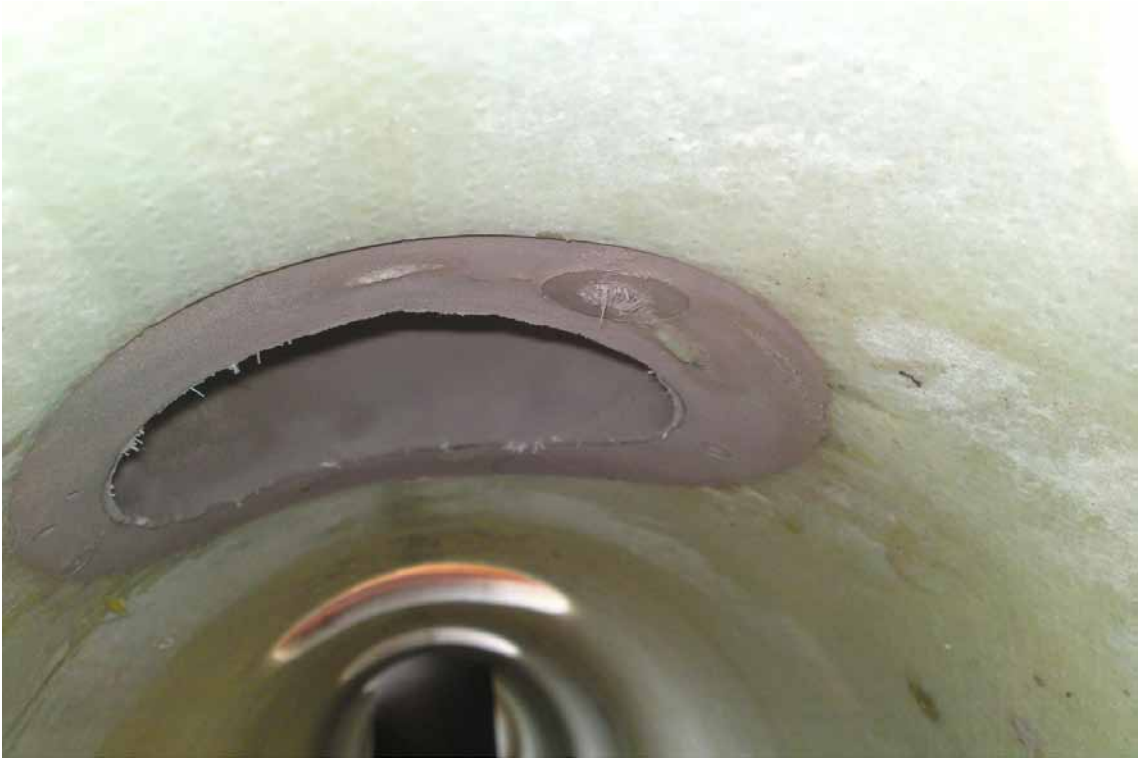
Nach der Reparatur: fachgerecht eingebundener Stutzen.
