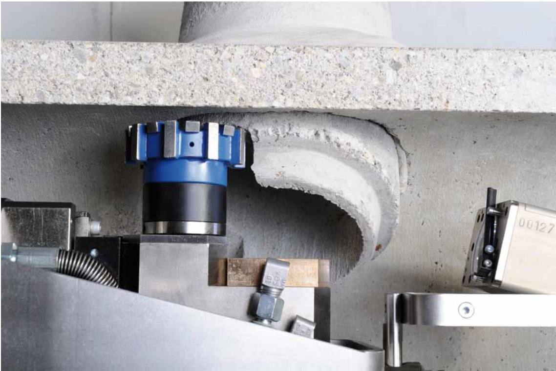
Auffräsen eines Zulaufs.
